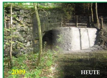
Mundloch des Weidtmannstollens
