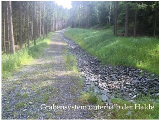
Aufgrund der mit dem Klimawandel zunehmenden Starkregenereignisse wurden 2014 zum Schutz der Halde Grabensysteme zur Ableitung von Oberflächenwässern zusätzlich angelegt. Ziel ist, die der Halde von oberhalb zuströmenden Niederschlagswasser um die Halde herum zu leiten und den Niederschlag vom Haldenplateau schnell abzuführen. Dazu wurden 3 leistungsfähige Grabensysteme 1. oberhalb, 2. auf der Halde und 3. unterhalb der Halde sowie ein Totholz- und ein Regenwasser - Rückhaltebecken neu angelegt.
