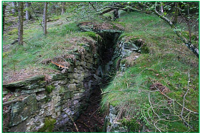
Ehemaliger, einzügiger Rauchgaskanal mit Abdeckplatte
